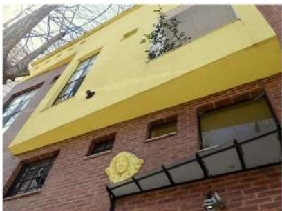
EDIFICIO CABRERA. J.A.Cabrera 4969. Palermo Soho.-
